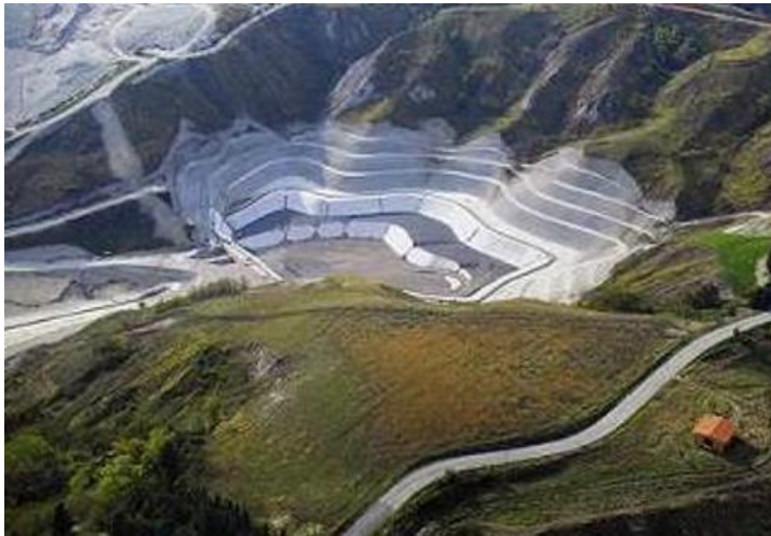
Fase di realizzazione
